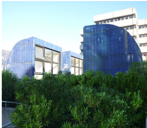
Détail des sheds assurant aux tennis lumière et ventilation 2015
